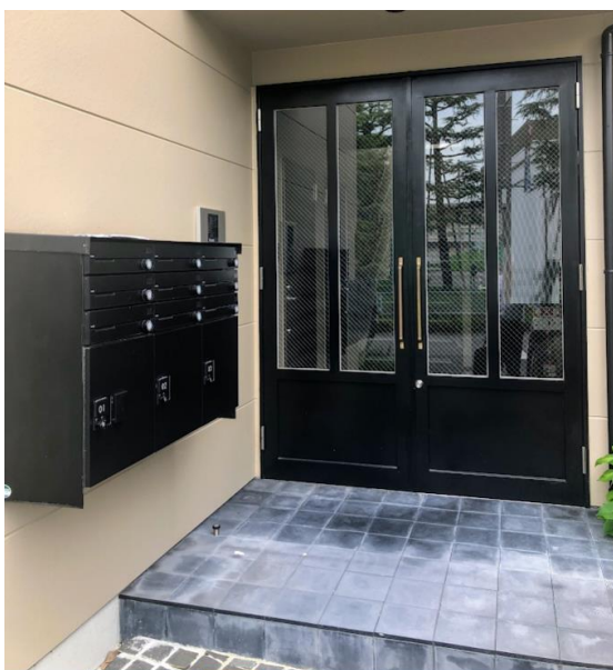
エントランス部分
